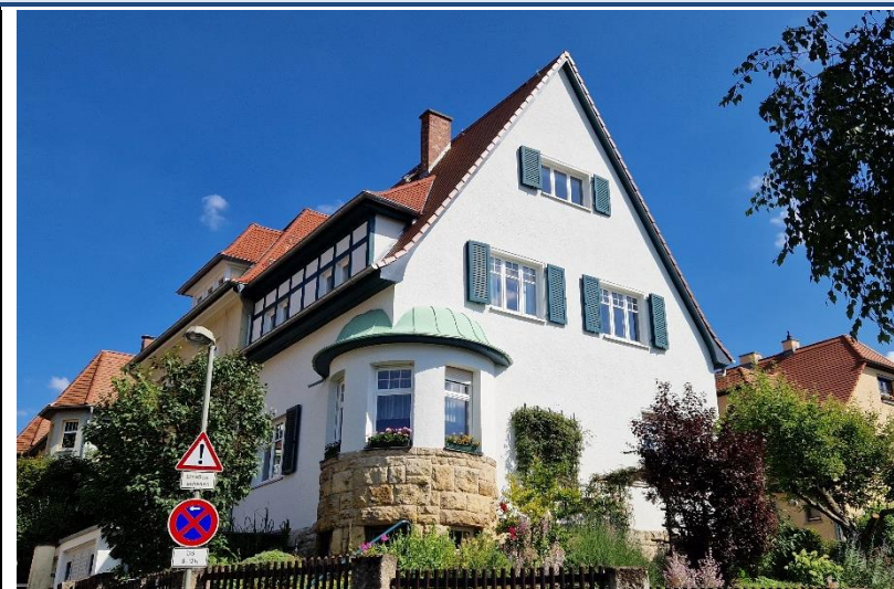
Bild: Helle reflektierende Fassade in der Leo-Sachse-Straße (Quelle: Stadt Jena)
